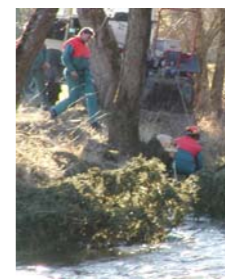
▲ Naturnahe Bauweisen: Raubaum
