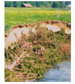
▲ Ein Raubbaum stabilisiert das Prallufer temporär.
