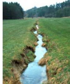
▲ Vorher: Sohl- und Ufererosion beschleunigen den Hochwasserabfluss.
