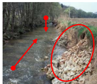
▲ Bach, ausgebaut: Sohle eingetieft, Ufer erodiert, Nutzung bis ans Ufer => Hier hilft eine Gewässeraufweitung mit Sohlanhebung.
