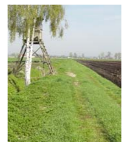
▲ Beidseitige Uferstreifen ggf. mit Fahrweg erleichtern die Unterhaltung (Zugänglichkeit). Auch werden dadurch unerwünschte Einträge aus angrenzenden Nutzflächen zurückgehalten.
